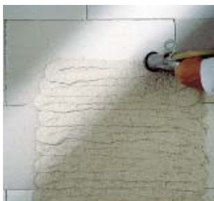
IŠLYGINAMASIS SLUOKSNIS DENGIAMAS RANKOMIS ARBA MECHANIZUOTU BŪDU, PO TO IŠLYGINAMAS. SLUOKSNIO STORIS TURI BŪTI 7 MM.
