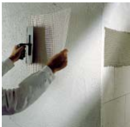
AKYTBETONIO IR KITŲ MEDŽIAGŲ JUNGIMO SIŪLĖS, ANGOKRAŠČIŲ KAMPAI PAPILDOMAI SUTVIRTINAMI STIKLO AUDINIO TINKLELIU IR PALIEKAMI 1-2 DIENAS DŽIŪTI.
