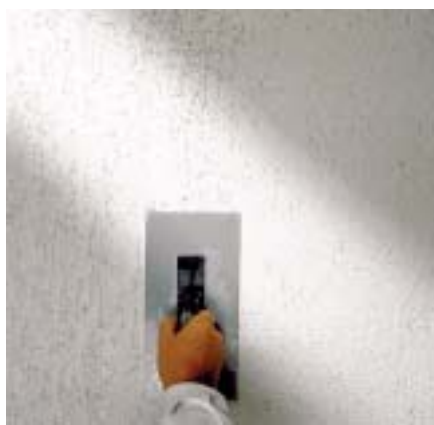
APDAILINIS SLUOKSNIS DENGIAMAS NERŪDIJANČIO PLIENO MENTELE IR UŽTRINAMAS. JEI NAUDOJAMAS SPALVOTASIS TINKAS, IŠDŽIŪVUSĮ SLUOKSNĮ BŪTINA DAR KARTĄ NUDAŽYTI „EGALISIERUNGSFARBE“ DAŽAIS.
