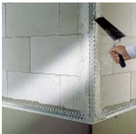
TVIRTINAMI KAMPINIAI IR COKOLINIAI TINKAVIMO PROFILIAI.
